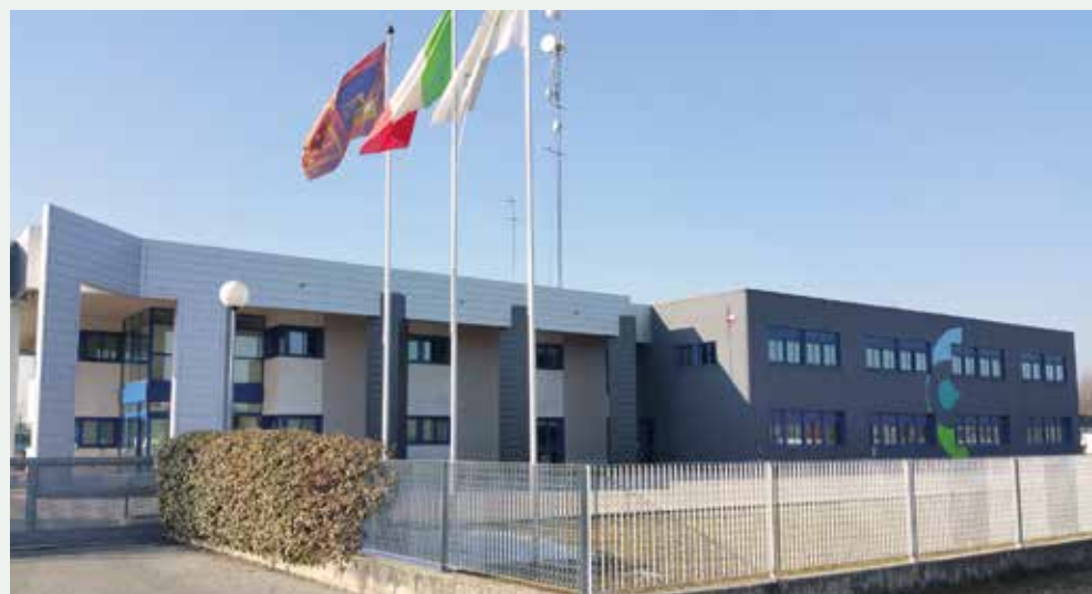
Sede Etra di Cittadella (PD)
